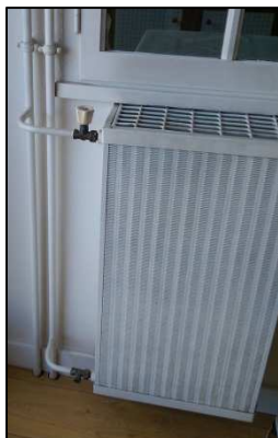
Figure 20 : Convecteur à eau chaude avec robinet simple réglage
