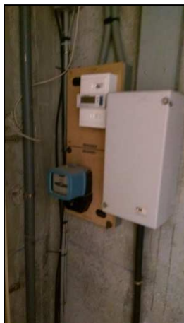
Figure 41 : Compteur électrique en gaine palière
