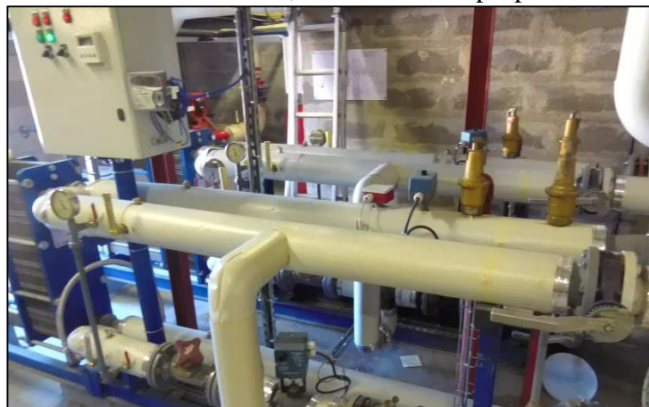
Figure 11 : Sous-Station alimentant les Bâtiments J, K & N
