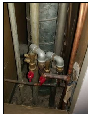
Figure 26 : Vanne de la colonne de distribution de l'eau chaude sanitaire
