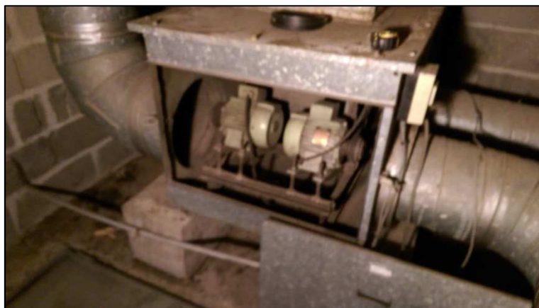
Figure 27 : Caisson d'extraction en combles
