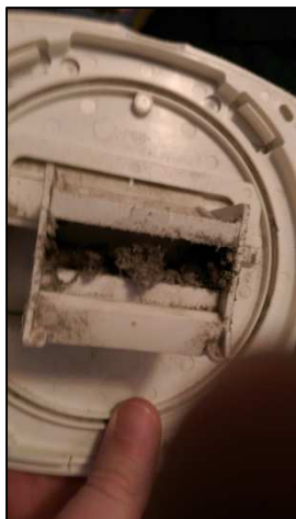
Figure 34 : Bouche d'extraction encrassée
