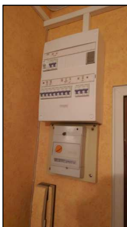
Figure 40 : Exemple de tableau électrique en logement remplacé
