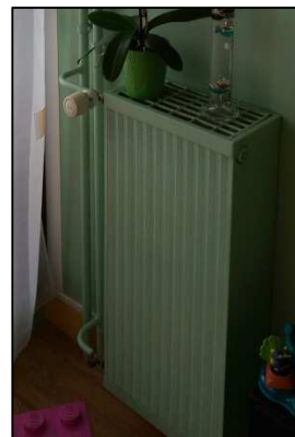
Figure 21 : Convecteur à eau chaude avec robinet thermostatique
