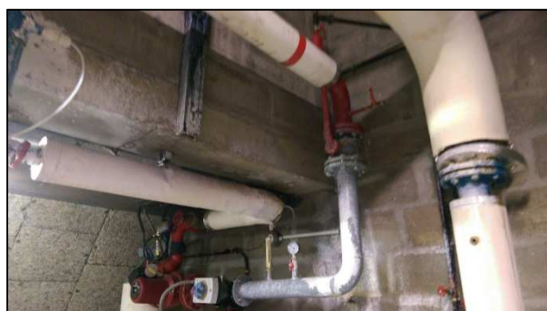
Figure 13 : Calorifuge manquant en Sous-Station
