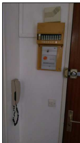
Figure 43 : Positionnement de la platine de rue et du combiné d'interphonie en logement
