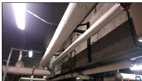
Figure 15 : Calorifuge abîmé en Sous-Station
