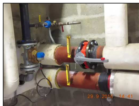
Figure 16 : Calorifuge manquant suite au remplacement d'une vanne
