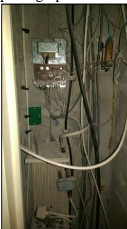
Figure 42 : Colonne télécom et télévision en gaine palière
