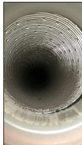
Figure 35 : Conduit entre colonne et bouche d'extraction
