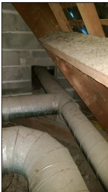
Figure 31 : Cheminement des gaines d'extraction en combles
