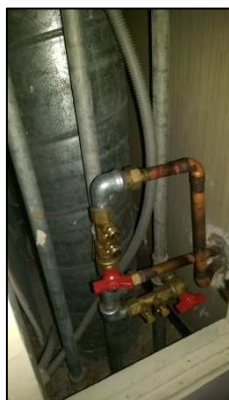
Figure 25 : Vanne de la colonne de distribution de l'eau chaude sanitaire en fin de réseau
