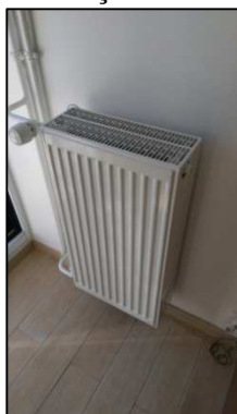
Figure 22 : Radiateur remplacé avec robinet thermostatique
