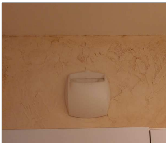
Figure 32 : Bouche d'extraction en salle de bains
