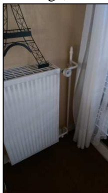
Figure 24 : Purgeur d'air au point le plus haut de la colonne de chauffage
