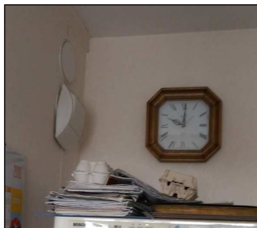
Figure 33 : Bouches d'extraction en cuisine avec commande du débit de pointe par cordelette
