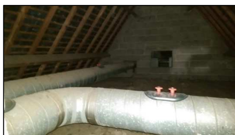
Figure 29 : Cheminement des gaines d'extraction en combles
