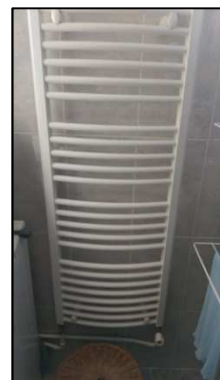
Figure 23 : Sèche-serviettes en salle de bains avec robinet simple réglage
