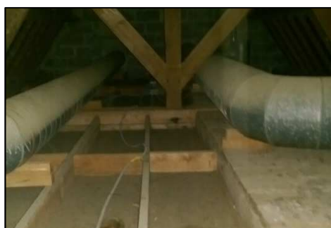
Figure 30 : Cheminement des gaines d'extraction en combles
